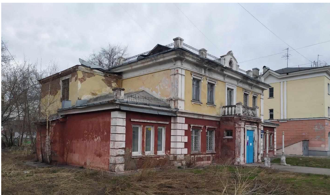
Боковой (западный) фасад. Фото Е.А.Благиных, 2020г.
