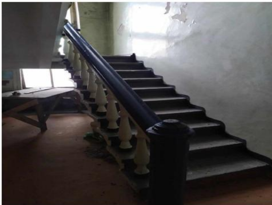
10. Ограждение лестничного марша. Фото Е.А.Благиных 2020 г.
