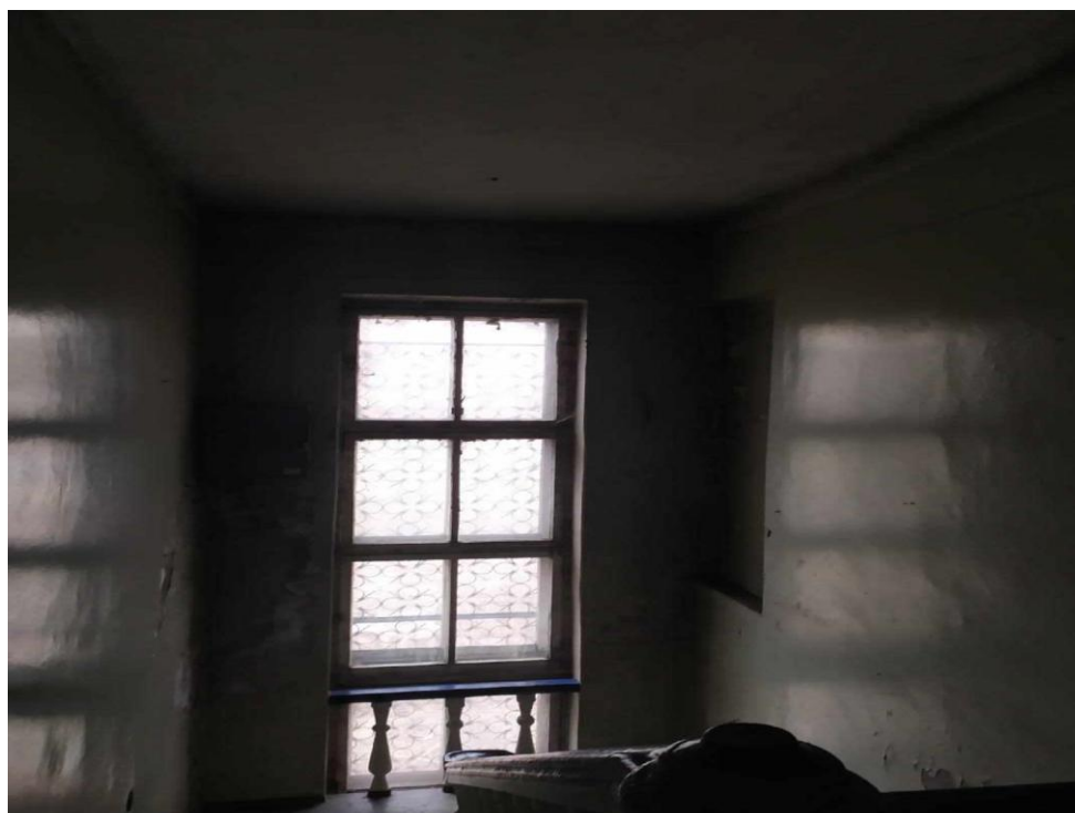
11. Ограждение промежуточной лестничной площадки. Фото Е.А.Благиных.
